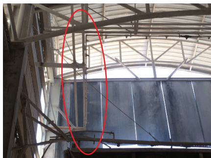
รูปที่ 2-29: ระบบสเปรย์น้ำของโรงโม่
