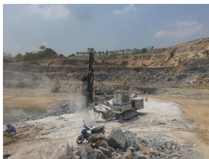
รูปที่ 2-22: การติดตั้งเครื่องดูดฝุ่นหัวเจาะ
